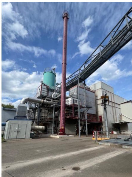
м.Карлсруе (котельня зі спалювання мулу)
